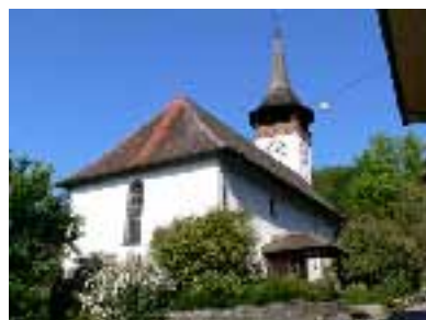
Eglise paroissiale de Wattenwil
