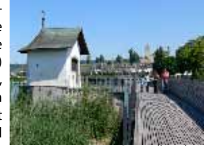
Passerelle en bois
